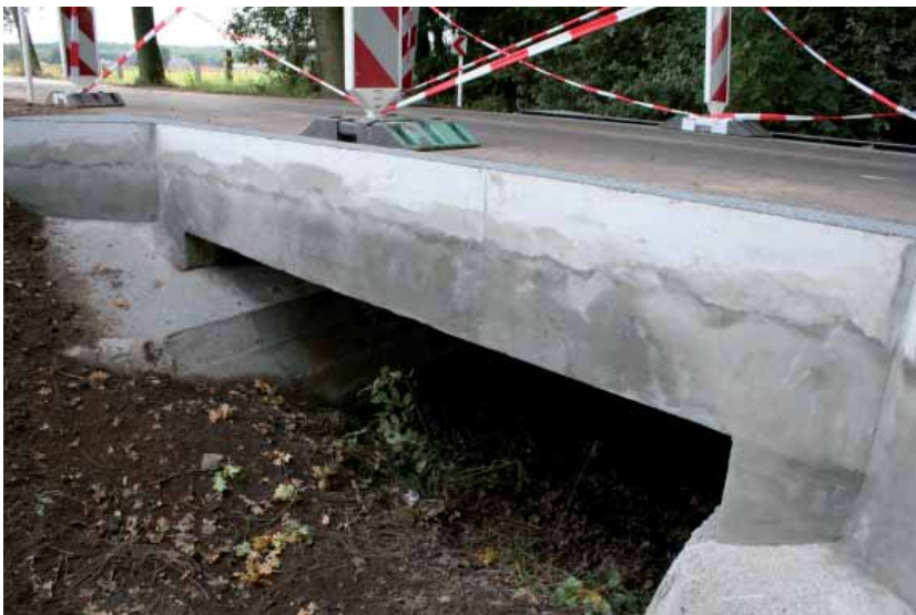
De gerestaureerde brug
