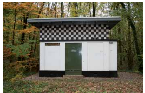
Het transformatorhuisje in het Kerkebosje, dat ook in oriëntaalse stijl gebouwd is, is ook een Rijksmonument.
