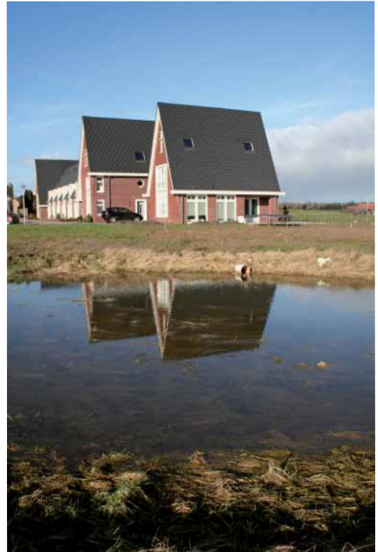
Het al gerealiseerde deel van de Parachutistenstraat. In de "wadi's" achter de huizen, verzamelt zich het regenwater, waar het wegzakt. Dat is goed voor het grondwater (anti-verdroging) en het ontlast de waterzuivering, omdat het water niet in het riool terecht komt.
