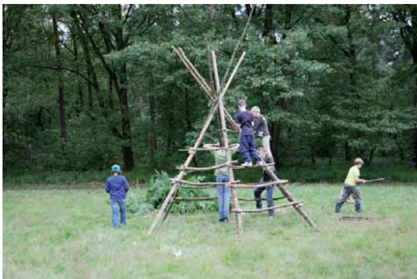
Tipi in aanbouw
