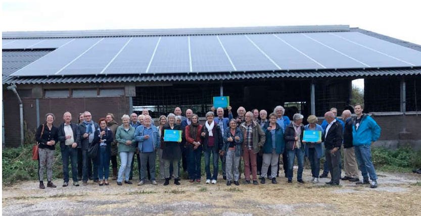
De leden van Coöperatie Energierijck voor hun zonnepanelen op het dak van zuivelboerderij Groenhouten in Leuth
