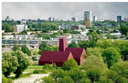
'De Kathedraal' in Den Haag. Voorbeeld van een geothermisch project midden in de bebouwde kom.
