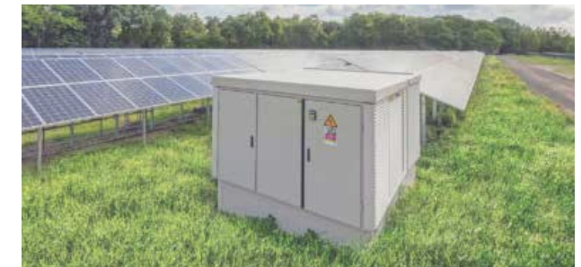
Referentie van een transformator.
